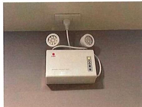
รูปที่ 22 ระบบแสงสว่างฉุกเฉิน
