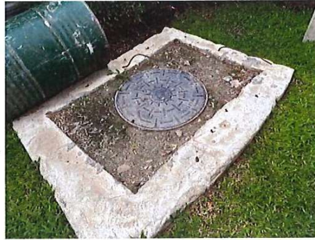
รูปที่ 8 บ่อดินบำบัดก๊าซมีเทนที่เกิดขึ้นจากระบบบำบัดน้ำเสีย
