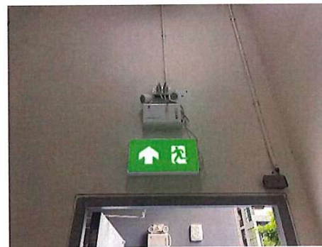
รูปที่ 22 ระบบแสงสว่างฉุกเฉิน
