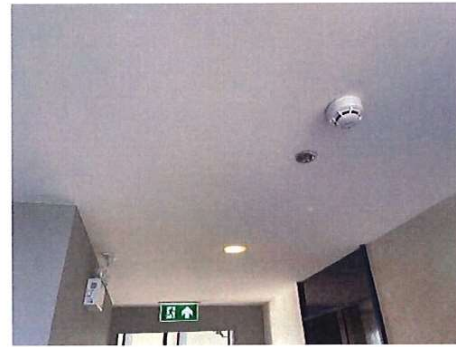
รูปที่ 33 ระบบดับเพลิงอัตโนมัติ (Sprinkle)
