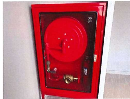
รูปที่ 32 ตู้เก็บอุปกรณ์ดับเพลิง
